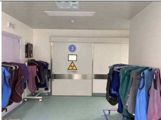
DSA3 室南侧洁净走廊
